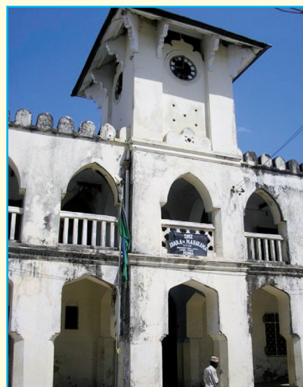
JENGO la Mahkama ya Chake Chake Pemba.
